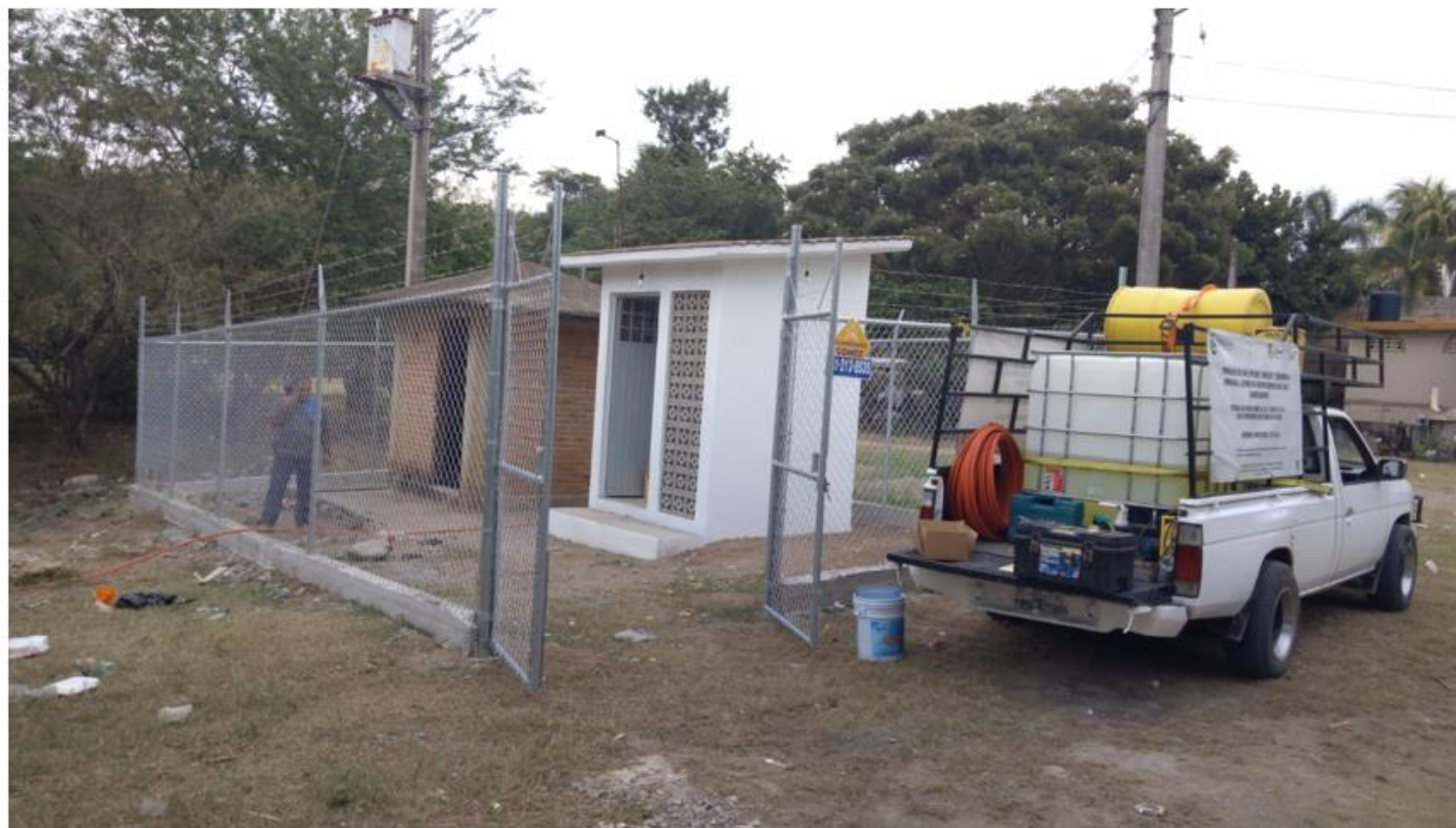
CASETA LAS PIEDRAS
